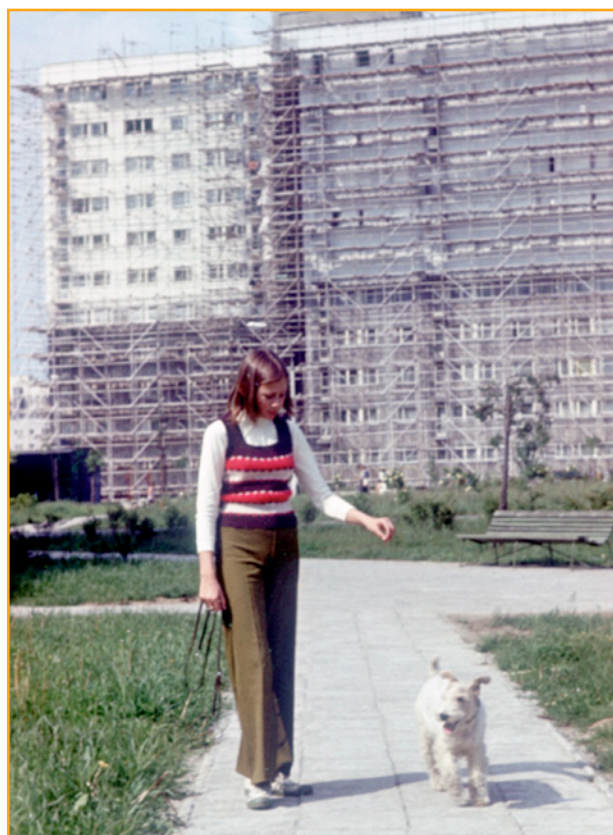
Blok przy ul. Raławickiej 150, połowa lat 70-tych XX w.
